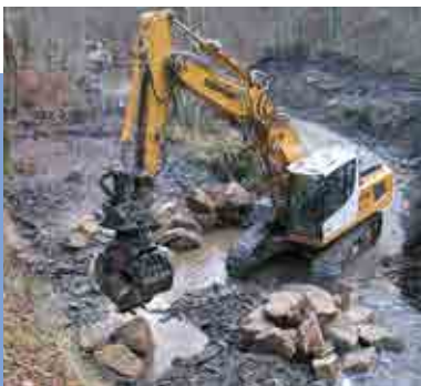
Der neue Gewässerarm wird ausgekoffert und das Bachbett mit Wasserbausteinen und Kies vormodelliert. Der Rest wird sich selbst überlassen. So bildet sich bereits nach wenigen Monaten eine intakte Bachsohle aus und die Ufer begrünen sich mit heimischen Pflanzen.
