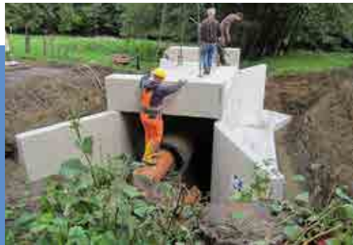
Bau der Brücke am Klafferbach, August 2014: Die Verrohrung wird erst später entfernt und dient so während der Bauphase noch der Wasserhaltung.
