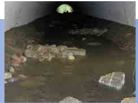
Erfolgreicher Umbau: Steinriegel im Durchlass unter der Panoramastraße direkt nach dem Umbau im Herbst 2015.
