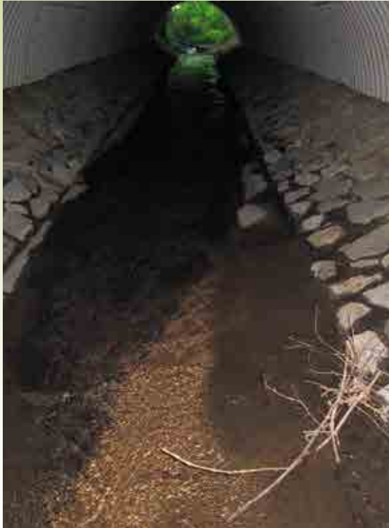
Durchlass unter der Panoramastraße vor dem Umbau im Juni 2014: durch eine 55m lange, glatte Betonsohle für Fische nicht passierbar.
