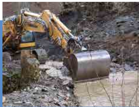
Der neue Gewässerarm wird ausgekoffert und das Bachbett mit Wasserbausteinen und Kies vormodelliert. Der Rest wird sich selbst überlassen. So bildet sich bereits nach wenigen Monaten eine intakte Bachsohle aus und die Ufer begrünen sich mit heimischen Pflanzen.
