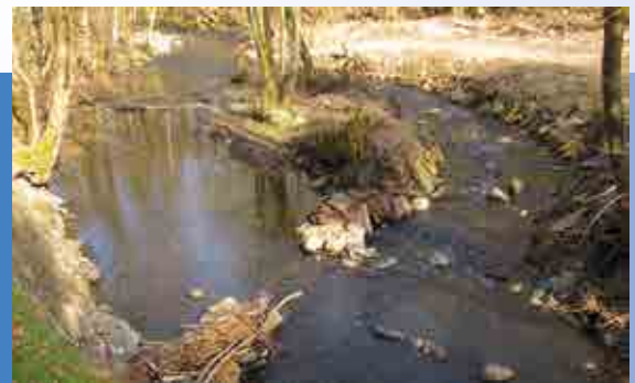
Nach dem Umbau: Blick auf die Kall stromabwärts im Bereich des Wehres: links der Rückstaubereich des Wehres, rechts der neue Gewässerarm.
