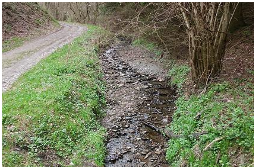
Abb. 15: Macherbach an der Probestelle mit deutlichen Geschiebeablagerungen, Blick bachauf.
