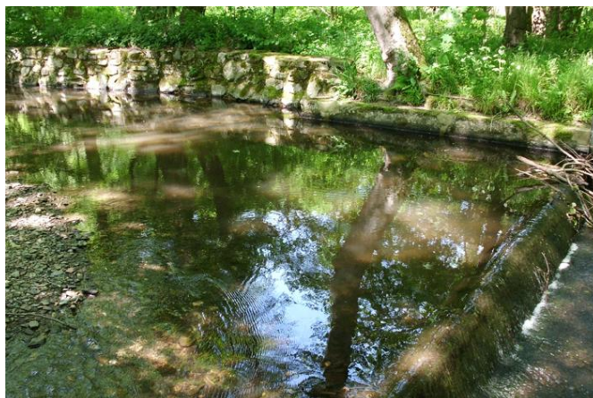
Abb. 08: K4, Probestelle, Blick bachauf
