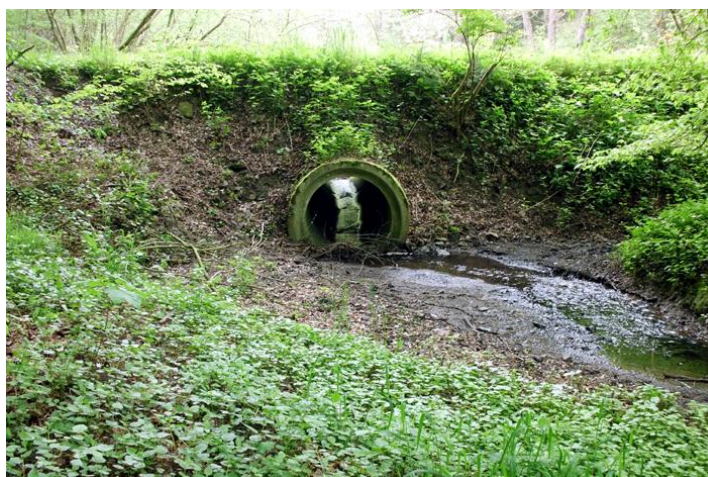
Abb.26: Bosselbach, alte Wegverrohrung, 2014
