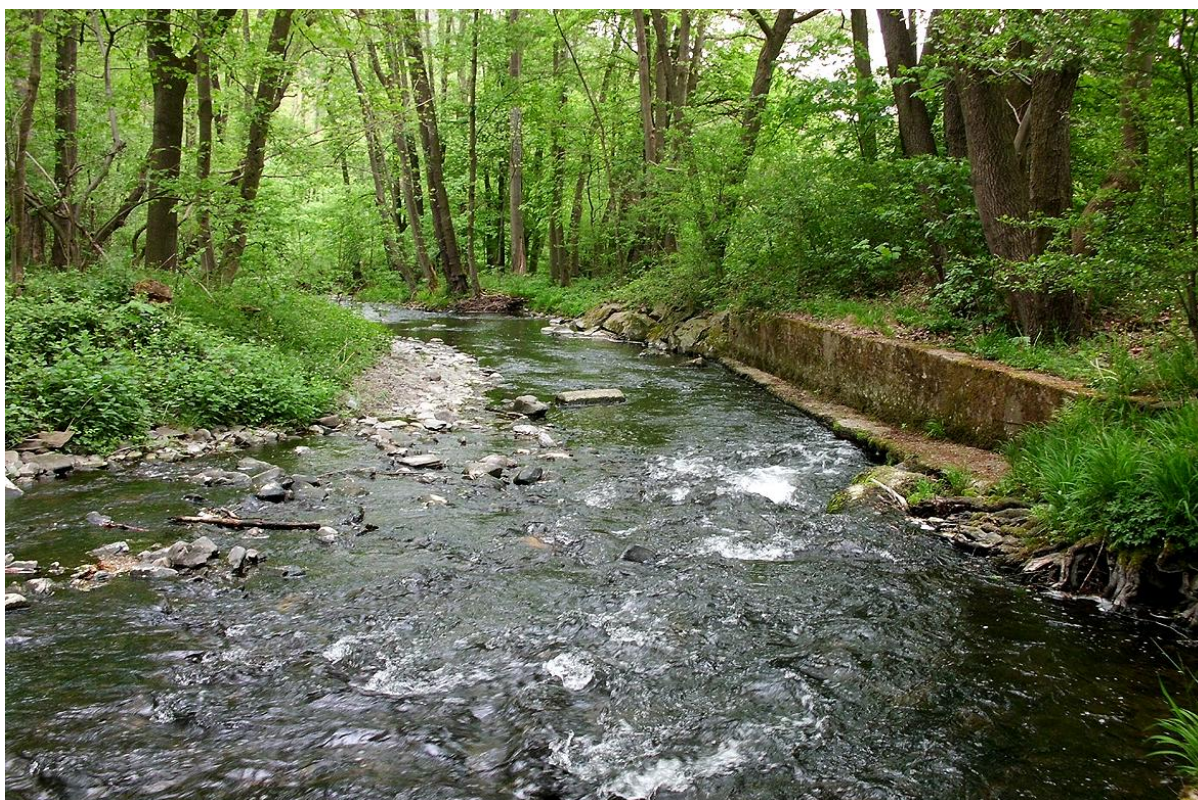
Abb. 12: K5, Probestelle, vom Stauwehr bachabwärts betrachtet
