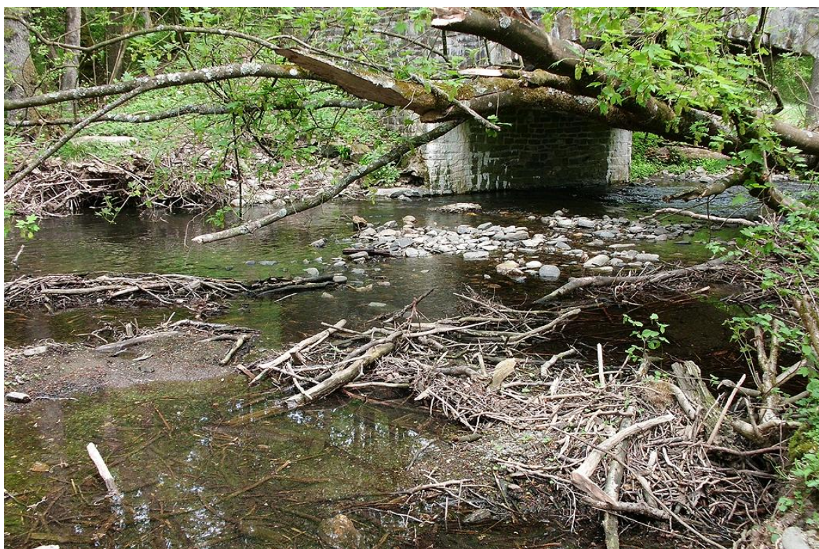
Abb. 02: K1 oberhalb der Brücke
