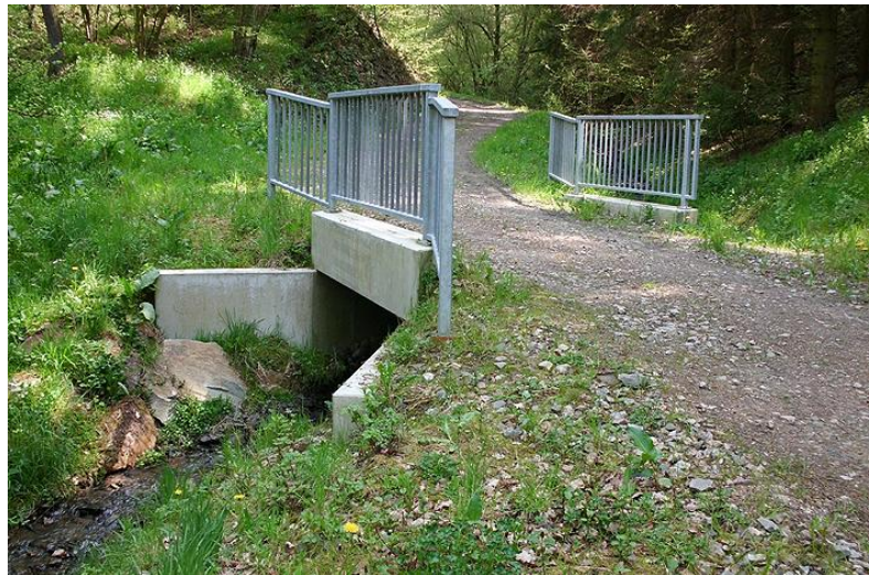
Abb.28: Macherbach, neue Brücke
