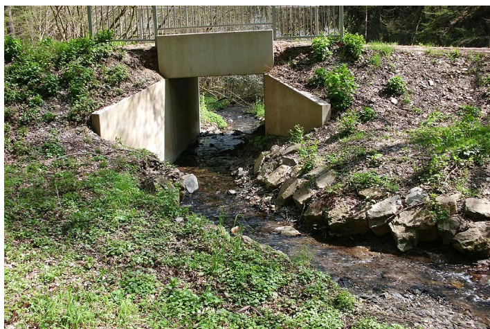
Abb.27: Bosselbach, neue Brücke, 2016
